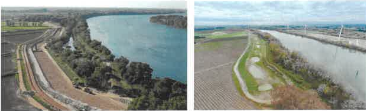
Photo 3. Démontage des digues d'origine, reconstruction en recul et création de zones humides (© Symadrem)
