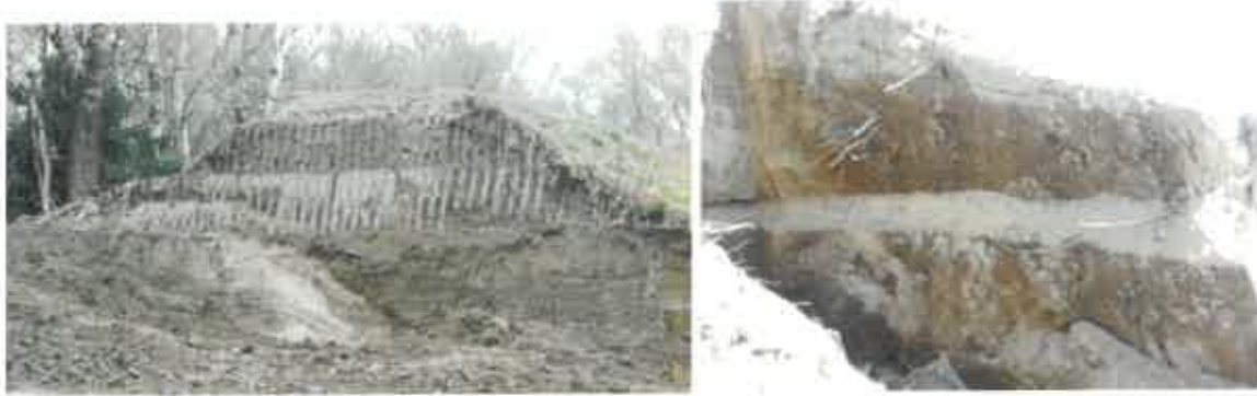
Photo 1. Digues du delta du Rhône – mille-feuilles et hétérogénéités (© Symadrem)
