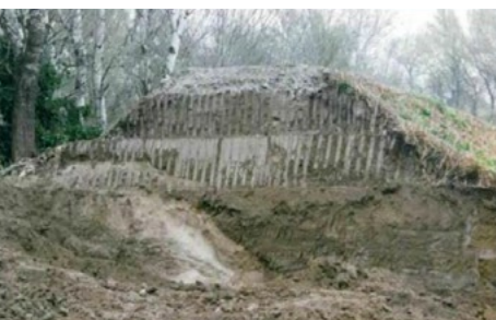
Ci-dessus : Coupe d'une ancienne digue avec plusieurs couches de terre visibles, qui en font un millefeuille
